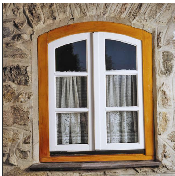
Fig. 4.3 : Après la peinture pour rénovation
