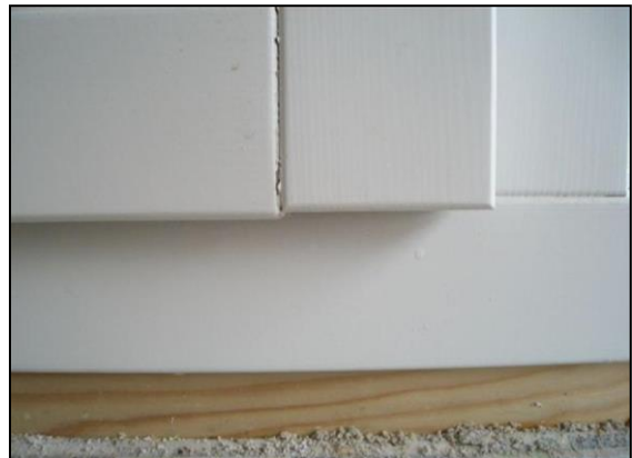
Fig. 3.3 : Joint en V ouvert
