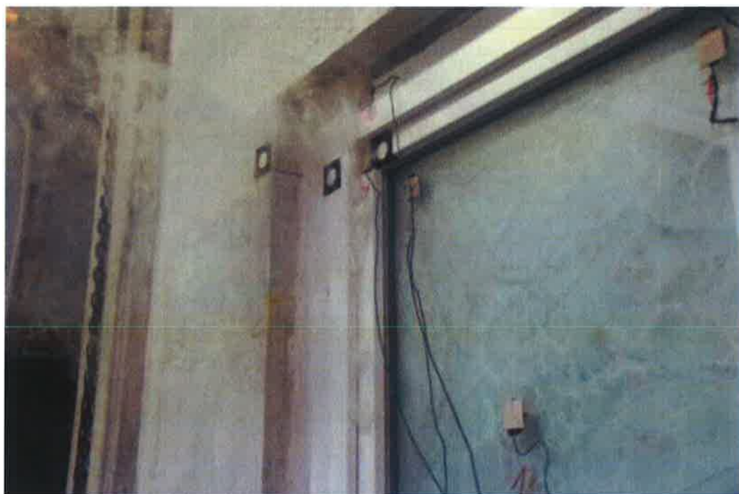
Abbildung 7: Rauchaustritt bei Probekörper 1 in der 24. Versuchsminute.
